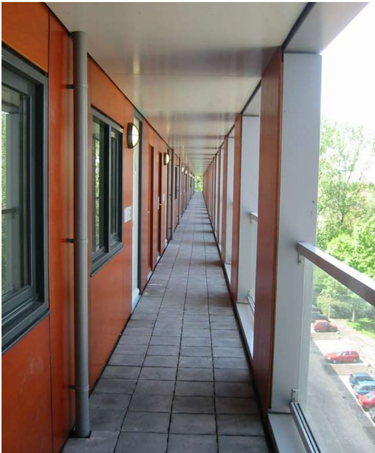
Galerij nieuwbouw, dakopbouw | Gallery penthouse addition
