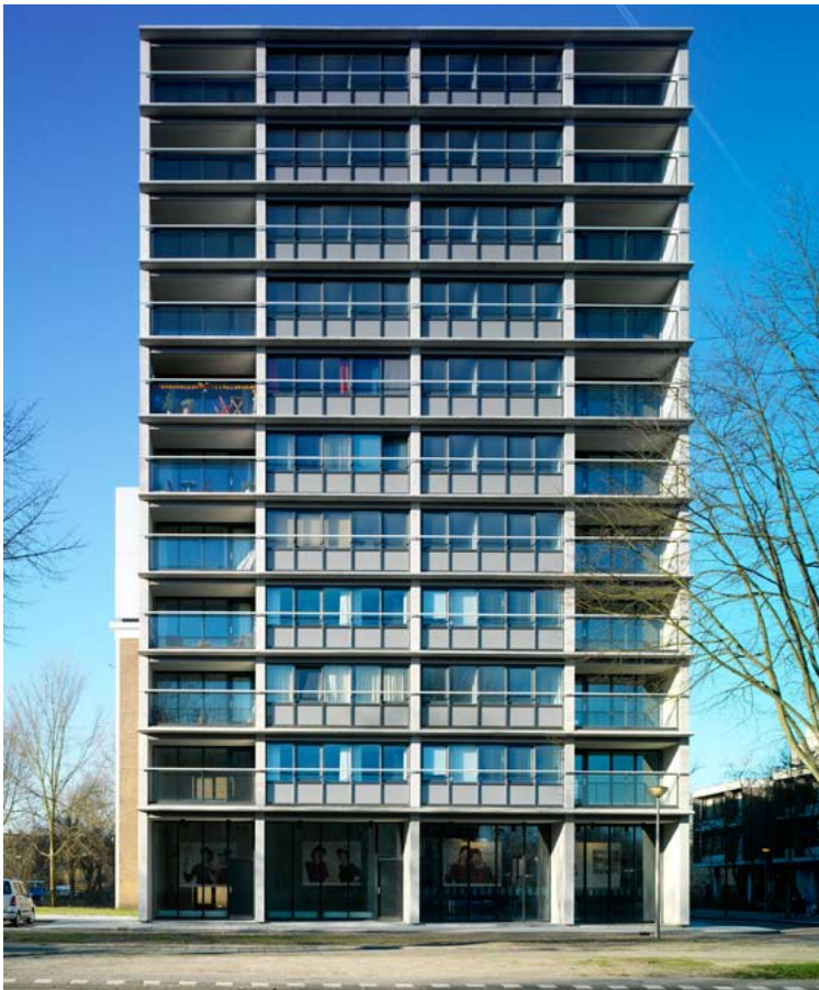
Voorgevel vanaf de Ildoornlaan | Facade Ildoornlaan
