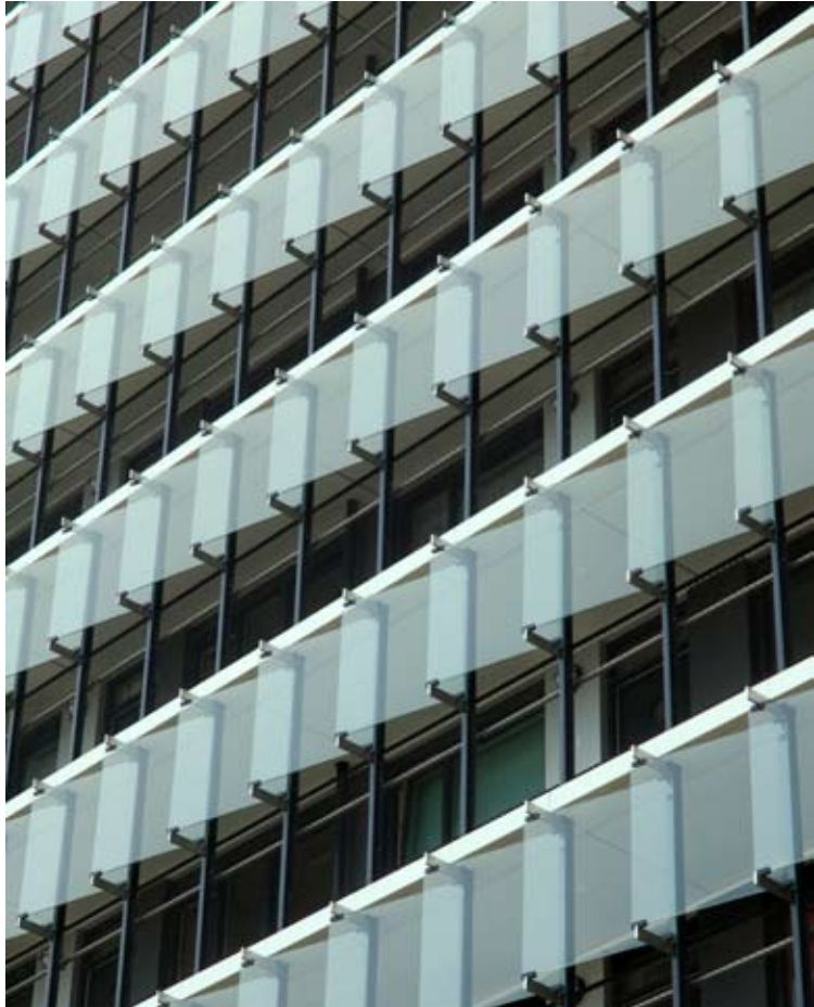
Boven: nieuwe lifthal hoge galerijflat met vliesgevel Onder: glazen vliesgevel galerijen op rvs uithouders
