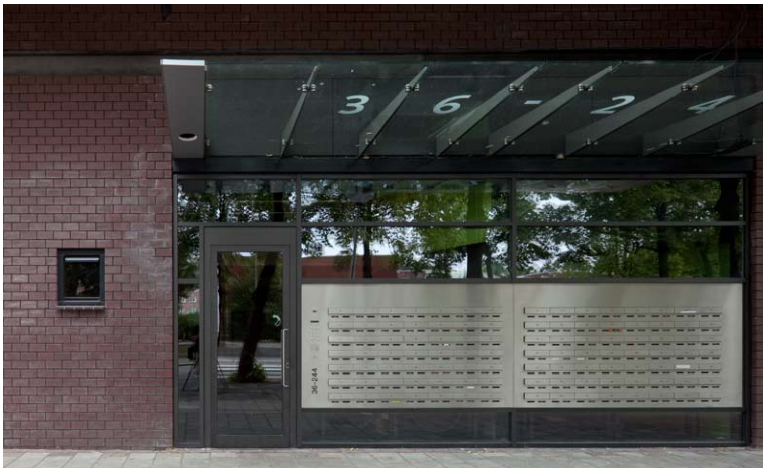
Boven: gevel torenflat Onder: nieuwe entree torenflat
