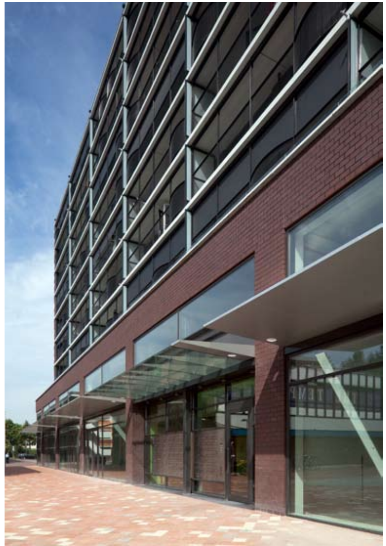
Nieuwe entree woningen hoge galerijflat
