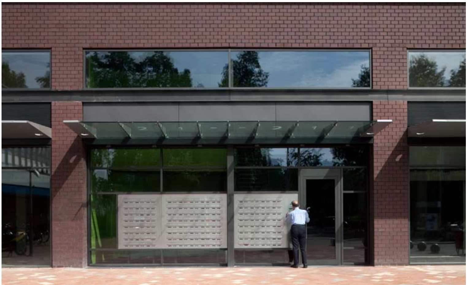
Boven: dubbelhoge entreehal hoge galerijflat met rvs postbussen en doorkijk naar liften en patio Onder: entree hoge galerijflat
