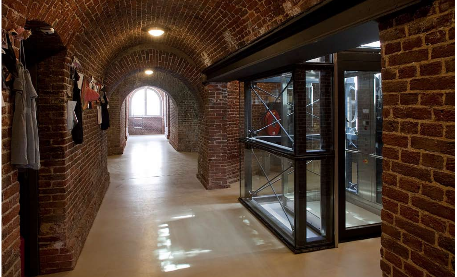
Souterrain met liftschacht
