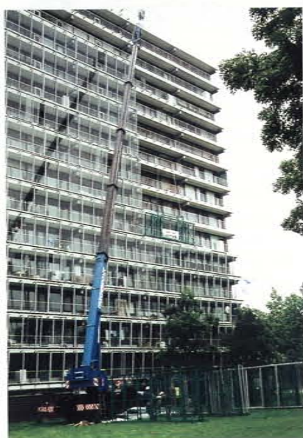
Blik op de montage met behulp van de kraan.
