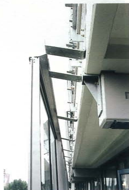
Een ingehangen pui met de extra bordesversterking goed zichtbaar.
