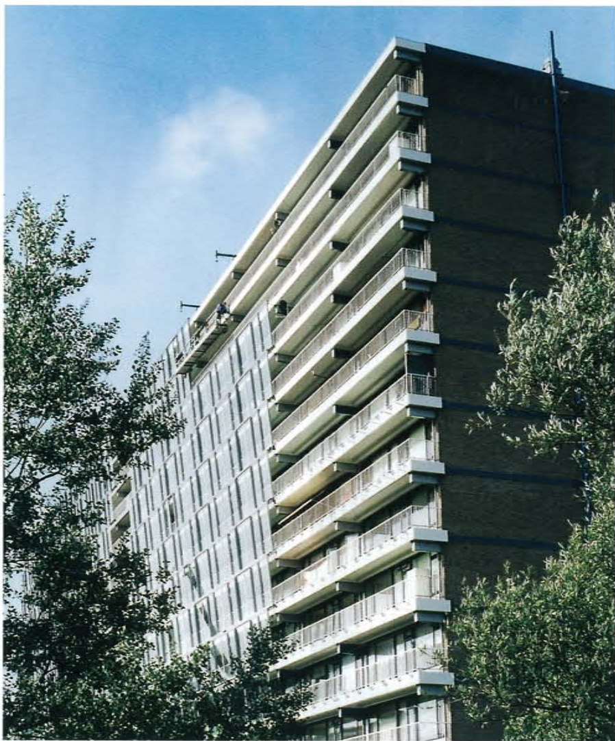
De Noordwachter tijdens de montage van de serregevels.
