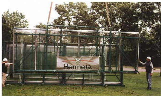
De 7,80 meter brede pui wordt in één keer ingehangen, waarbij de speciale hijsbeugel onmiddellijk voor de juiste helling zorgt.
