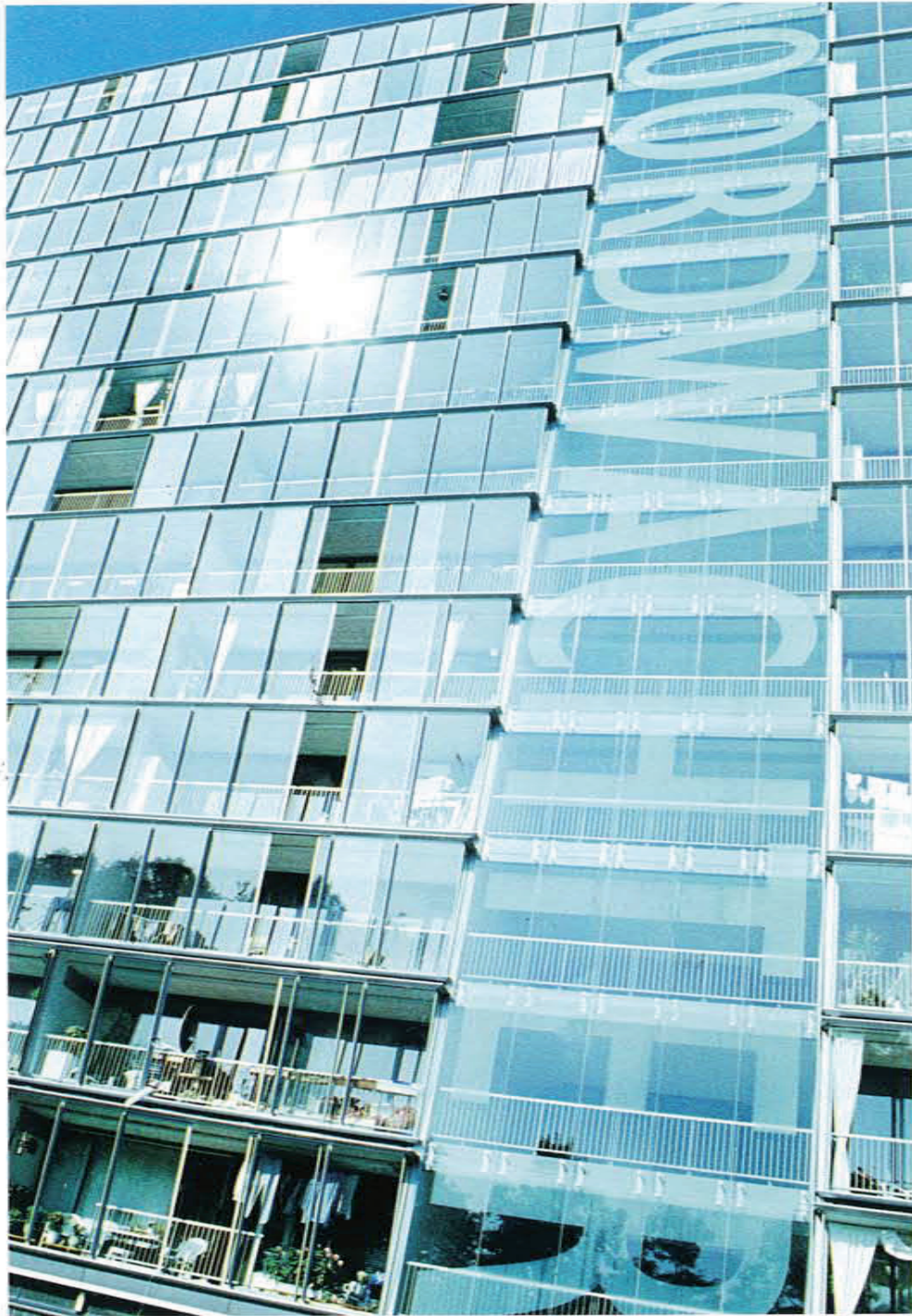
1 Levendige voorgevel van de Noordwacht. Lively facade of the Noordwacht building.
