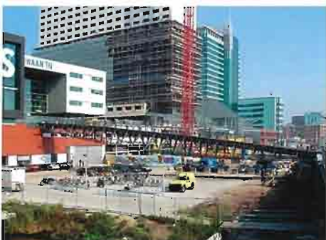
De Zouthavenbrug in aanbouw met links het Muziekgebouw.
