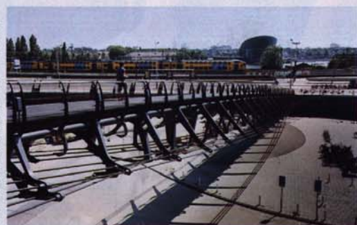
ミュージックヘボウに架かる橋。鉄骨の骨組みを、テクニカルにつなぎ合わせている。
