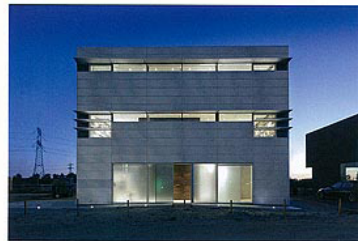
Côté rue, la façade est bardée de panneaux d'aluminium mobiles assurant la ventilation.
