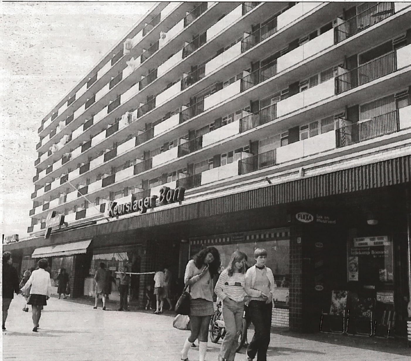
De galerijflat op het Waterlandplein in Amsterdam-Noord begin jaren zeventig.
