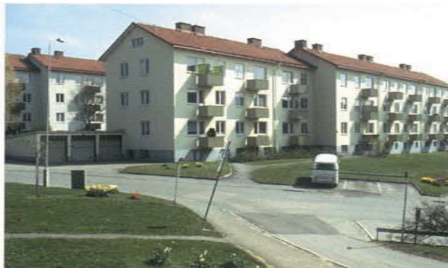
(boven) Järnbrott, Göteborg. Situatie vóór renovatie. (rechts) Järnbrott, Göteborg. Situatie ná renovatie met dakgeïntegreerde zonnecollectoren.
