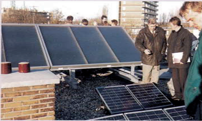
Catharinaland, Den Haag. Zonnecollectoren, met op de voorgrond PV-modules.
