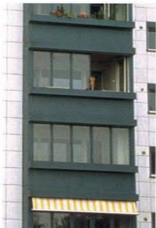
Glattbrugg, Zwitserland. Balkons verglaasd met dubbel glas.
