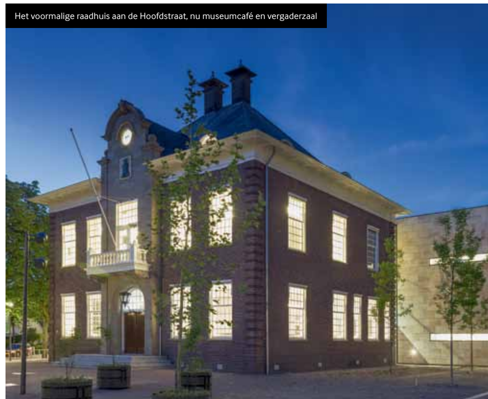
De gevels zijn bekleed met Frans kalksteen, waarin de hoge ramen steeds contact met buiten mogelijk maken.
