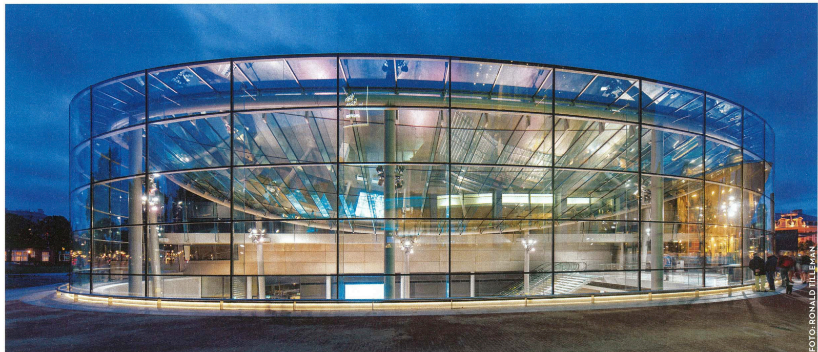
↑ Sklenené nosníky preklenuli rekordné rozpätie 12 m.
