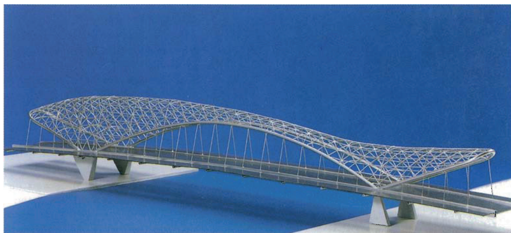
Model van de brug gebaseerd op het eerste ontwerp met voor de eenvoud een enkele rij ophangstaven.
