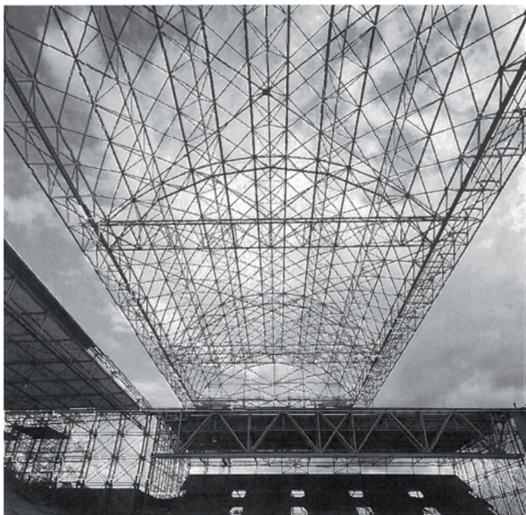
Het idee van een constructie met stalen netwerkschalen ontstond bij het ontwerp voor het dak van het Gelredome in Arnhem.
