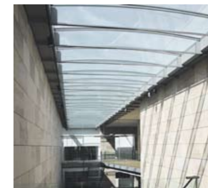
De bijzondere lichtstraat met koudgebogen glas op gelamineerde glazen liggers.
