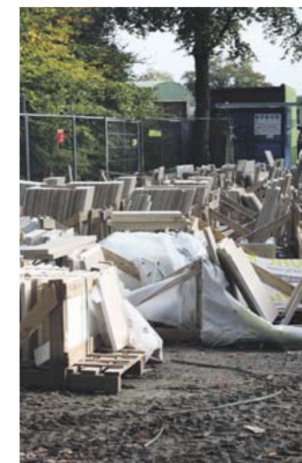
Een enorme hoeveelheid natuursteenplaten in twee soorten, namelijk een mix van Franse kalksteen (Beauval en Beaunotte).
