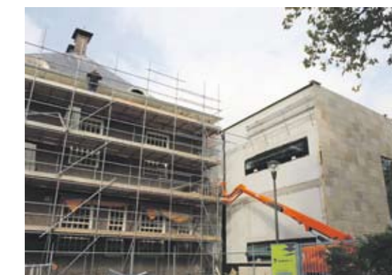
Het oude gemeentehuis uit 1914 is zoveel mogelijk in de oorspronkelijke staat hersteld. De gekozen natuursteen sluit goed aan bij de middenrisaliet van het oude pand.
