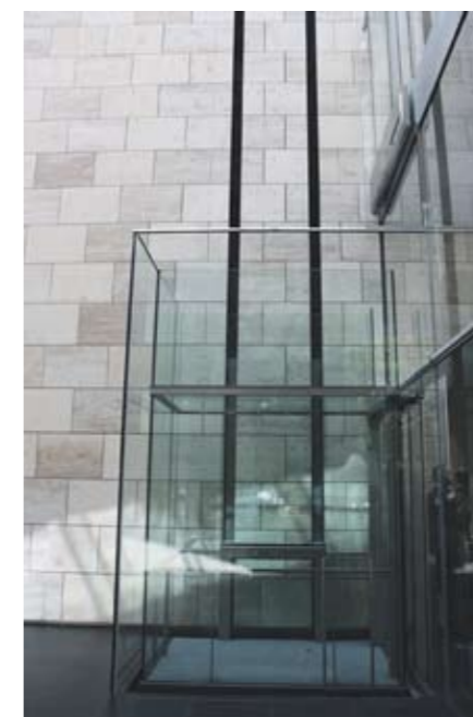
De natuursteen gevelbekleding loopt naar binnen door. Onder meer de geleiding van de glazen lift is zorgvuldig weggewerkt.
