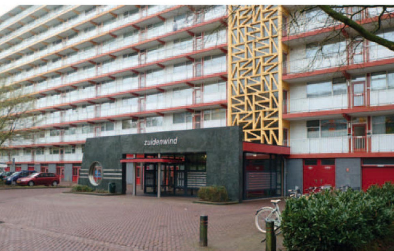
De oude, later aangebouwde entrees waren geen verbetering en het kunstwerk voor het trappenhuis was vervuild. (Foto: Dick de Gunst)
