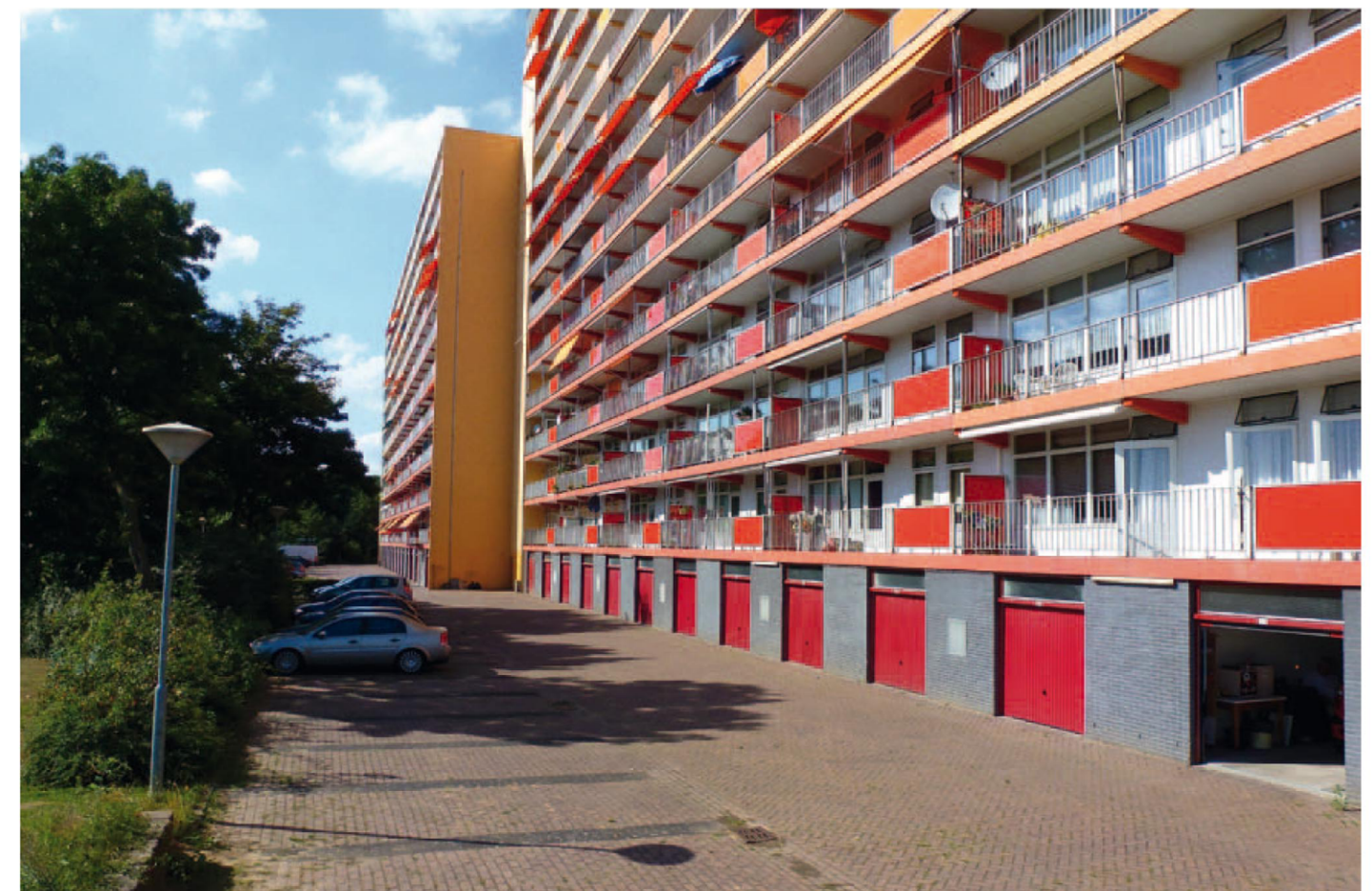
De oude balkons waren smal; de bevestiging van de balustrades vertoonde speling en privacyschermen boden weinig privacy. (Foto: Dick de Gunst)
