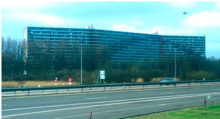
Flatgebouw voor renovatie | Housing block before renovation
