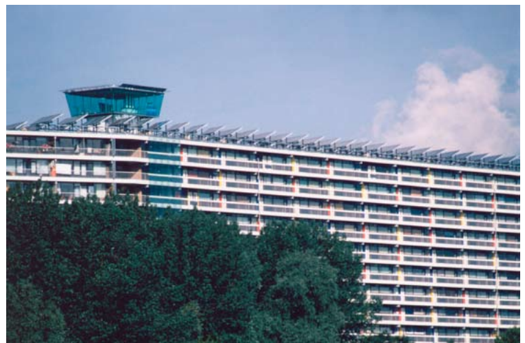
Dakpaviljoen met zonnecollectoren | Roof pavilion with solar panels
