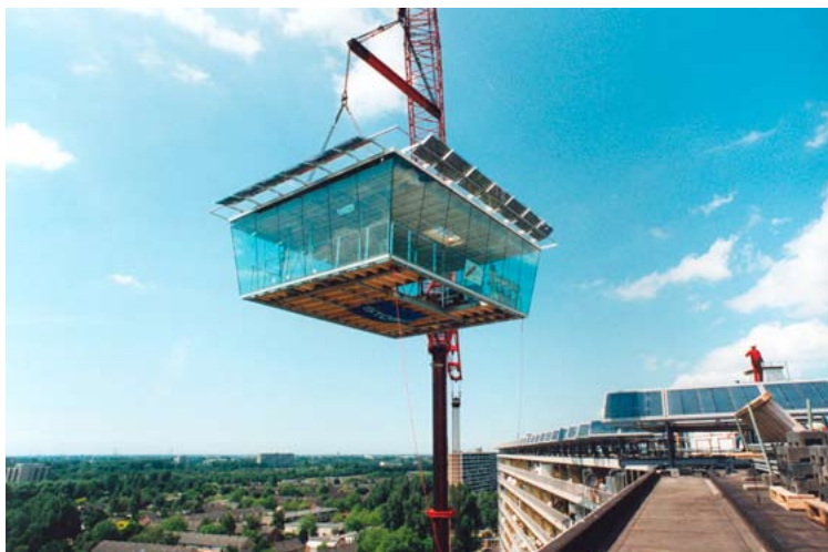
Dakpaviljoen in aanbouw | Placement of roof pavilion
