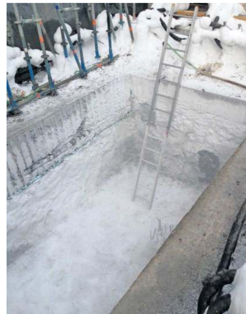
Het bevroren van de grond gebeurde met lansen die om de 60 centimeter aan de rand van de toekomstige put in de grond worden gestoken. Foto: Van der Spek
