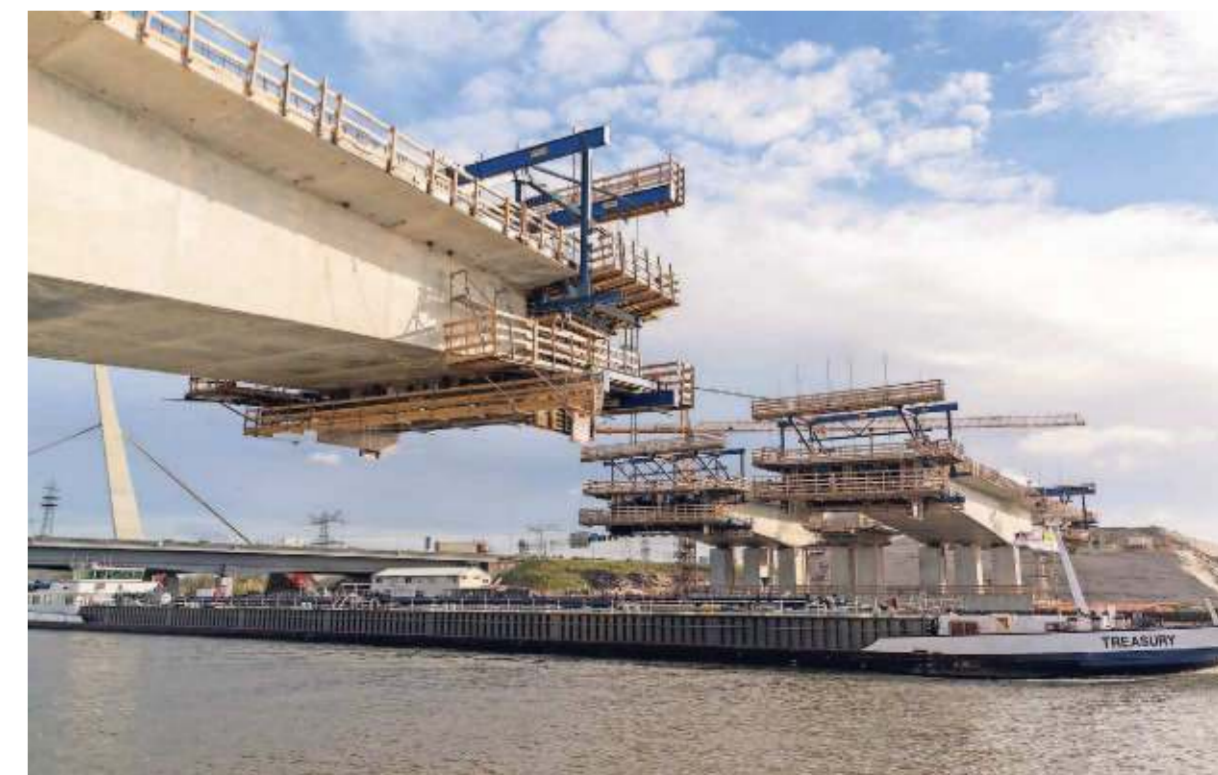
Omdat opdrachtgevers vaak kozen voor tuibruggen met veel architectonisch spierballenvertoon, raakte de vrije voorbouwmethode de laatste jaren wat in de vergetelheid. Foto: Doka
