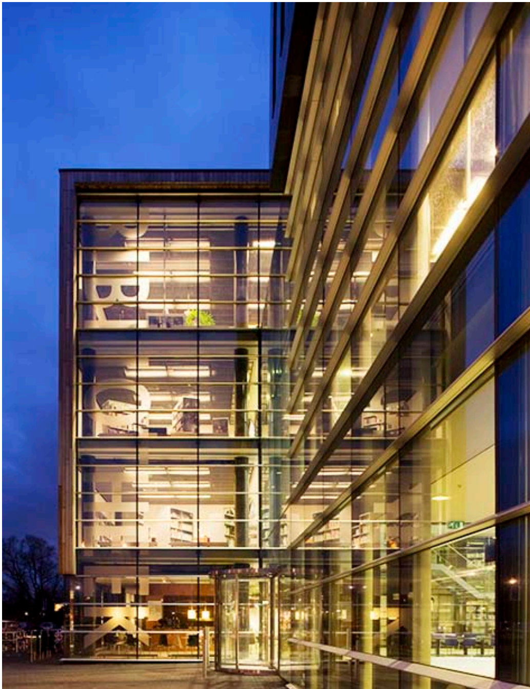
Voorgevel met hoofdentree. Front facade and main entrance.
