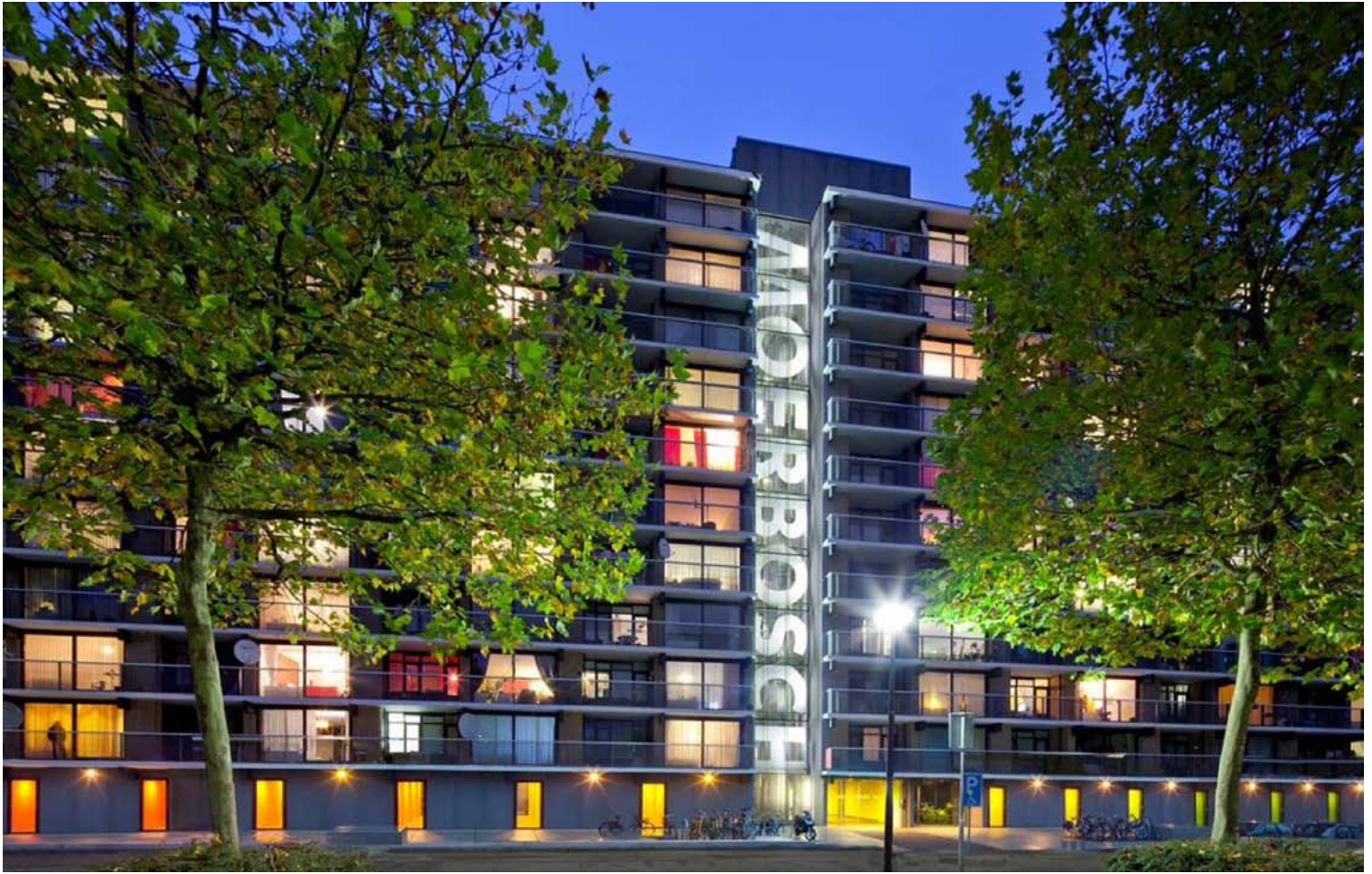
Zuidgevel en hoofdentree na de renovatie | South facade and main entrance after renovation
