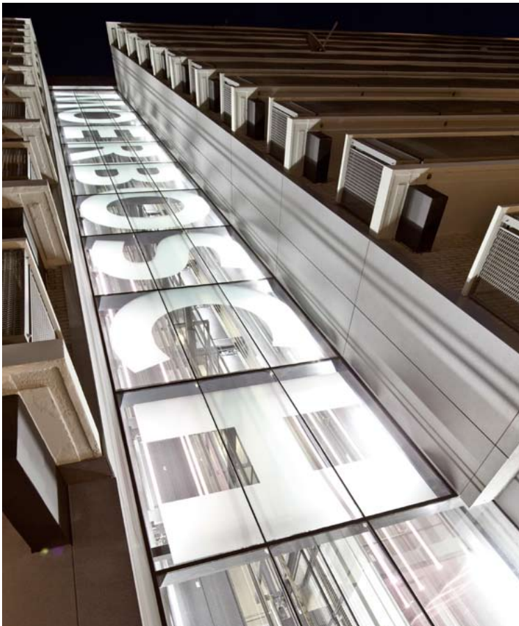
Opengewerkte liftschacht | Lift shaft cut open
