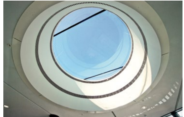
De met SGP gelamineerde daklichten overspannen 4.300 millimeter. Foto: BRS Building Systems
