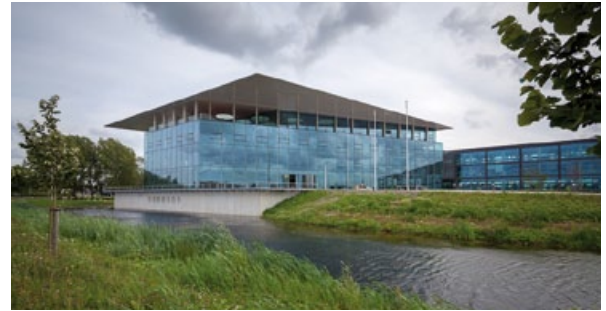
Het gemeentehuis van Lansingerland kreeg een flink dakoverstek en zonwerende beglazing zodat het in de zomer behaaglijk blijft. Foto: Imre Csany.
