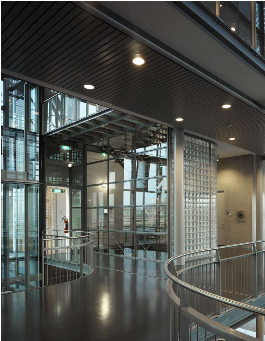
De liften hangen net als de gevels van de hal aan het dak. Zij bevinden zich in een vide achter een volledig glazen schachtfront en glazen deuren. The lifts, like the hall facades, are suspended from the roof. They are situated in a void behind a fully glazed shaft and glass doors.
