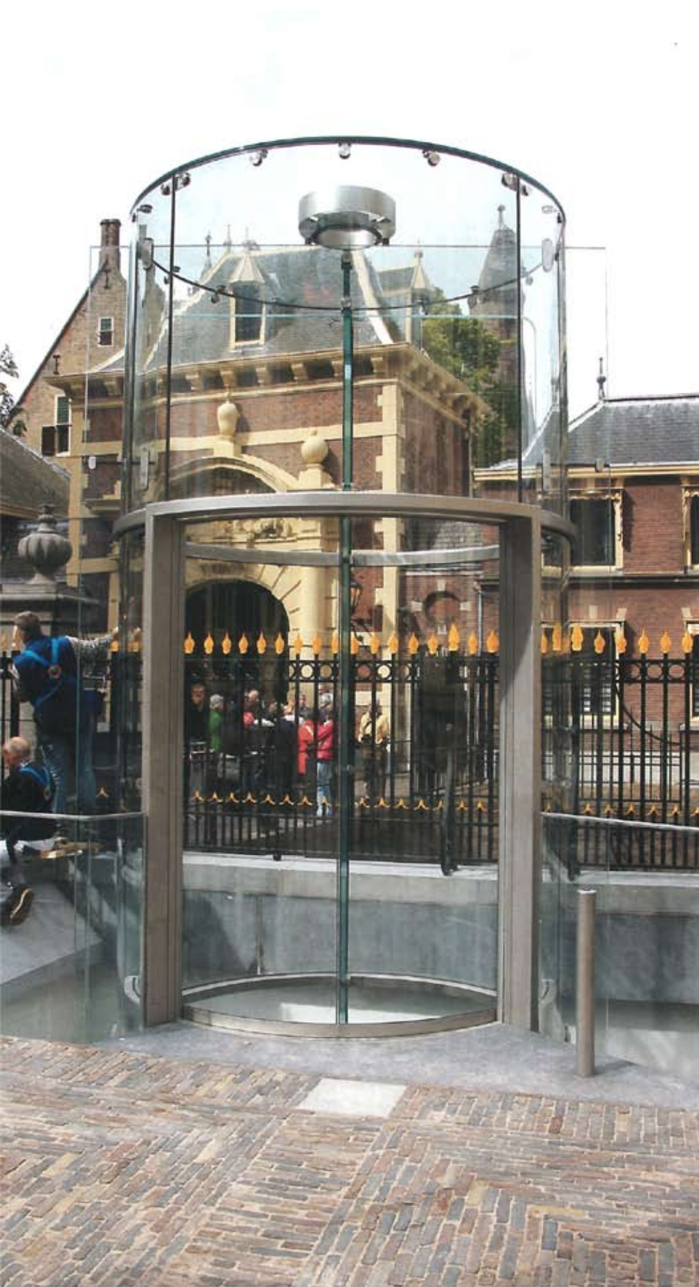
De glazen wanden van de liftkoker nemen de drukkrachten op; de glazen vinnen de trekkrachten. De vinnen zijn bovenin verbonden middels een U-vormig glasdeel van ongeveer een meter hoog.
