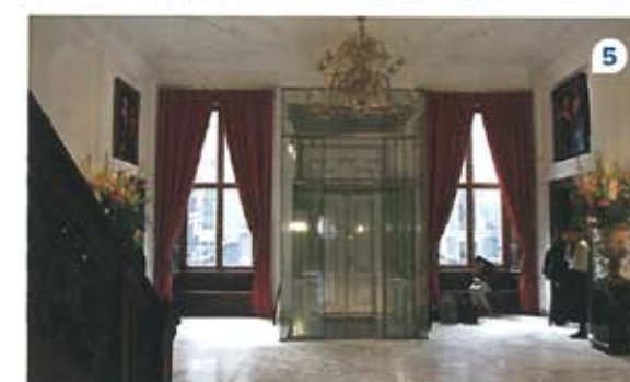
1 // Als de lift bereden is, is op de verdieping alleen een glazen tochtportaal zichtbaar voor de monumentale voordeur. 2 // Het vloerdeel in de liftkoker is uitgevoerd als een tafel met vier poten. 3-4 // De lift tilt de tafel met de vier poten mee omhoog. 5 // De lift is gearriveerd.
