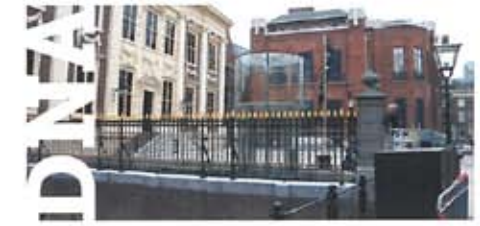
Liftkoker Mauritshuis // Locatie: Plein 29, Den Haag // Opdrachtgever: Stichting Koninklijk Kabinet van Schilderijen Mauritshuis // Bouw: juni 2012 – juni 2014
