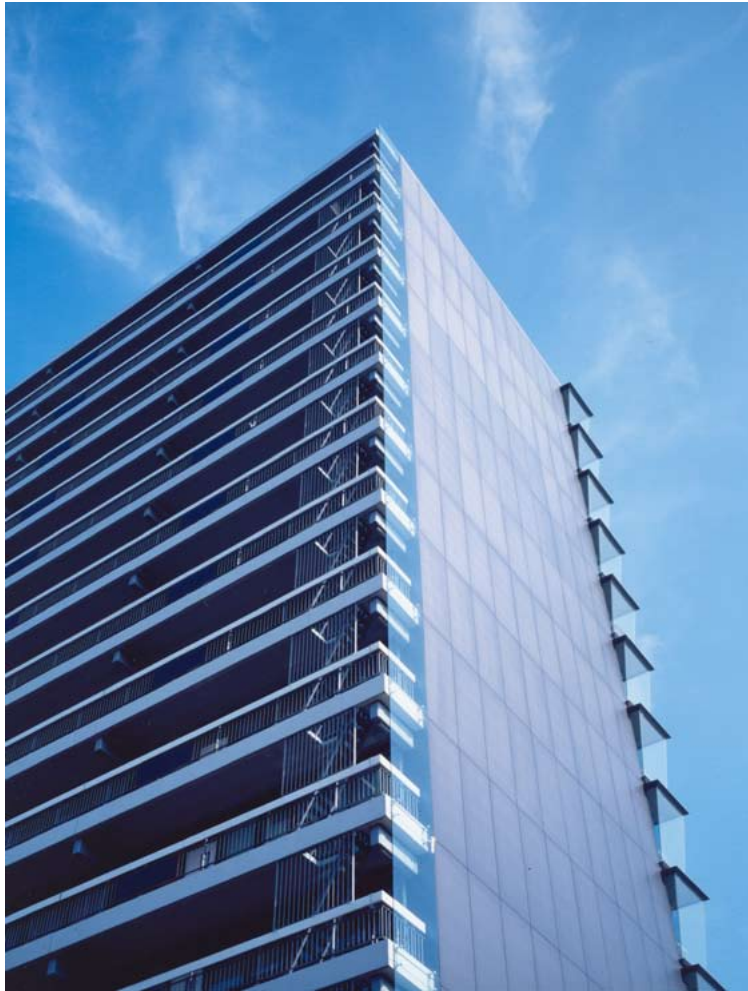
Kopgevelisolatie | Facade with insulation
