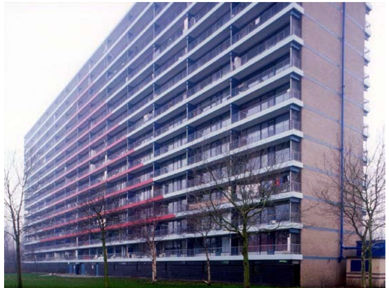
Noordwachter voor de renovatie | Noordwachter before renovation
